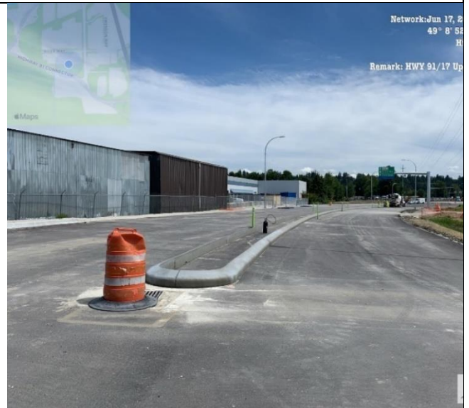
Photo 50: L1300(H). Concrete pour for curbs
