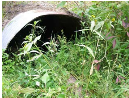
Photo 7: Mit Lake – blocked spillway culvert
