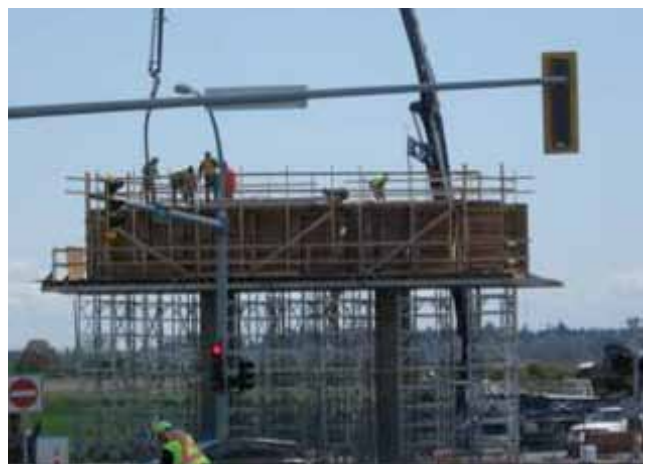
Pier cap concrete pour
