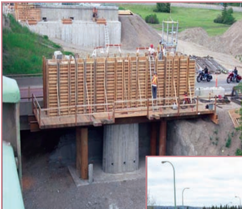
Pier 4 pile cap
